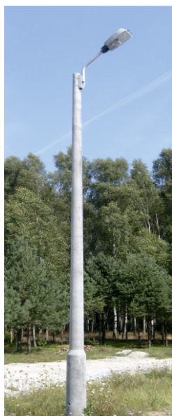
Mocowanie kotpaka wysięgnika
